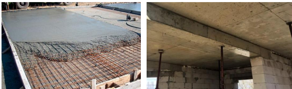
Сурет 3. Монолитті бетон қосылған құрама бетон төбесі
