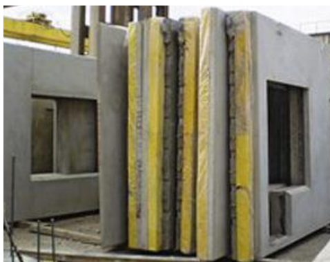
Сурет 1. Үш қабатты темірбетон панельдері
