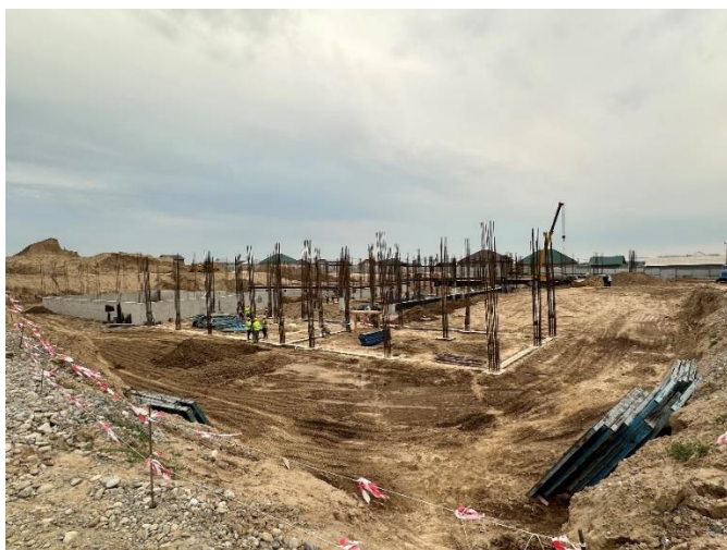
Рисунок 1. Общий вид строительной площадки школы в селе Аксу
